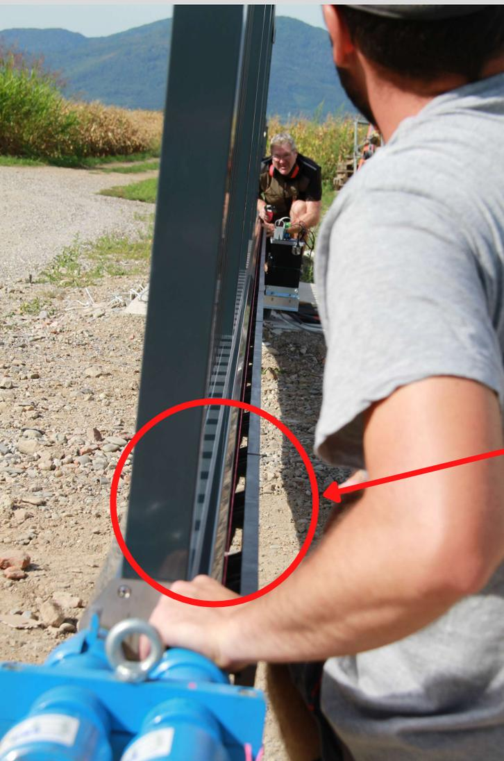
Vérification avec une ficelle de la ligne de la poutre
