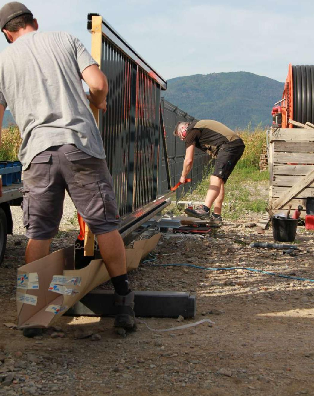
Desserrage des deux vis de la triangulation ↴
